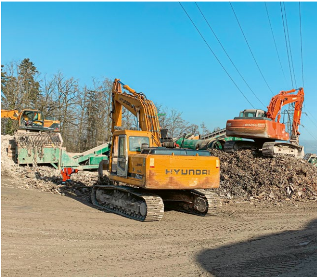
Für die Beladung der Förderbänder kommen Bagger zum Einsatz.
