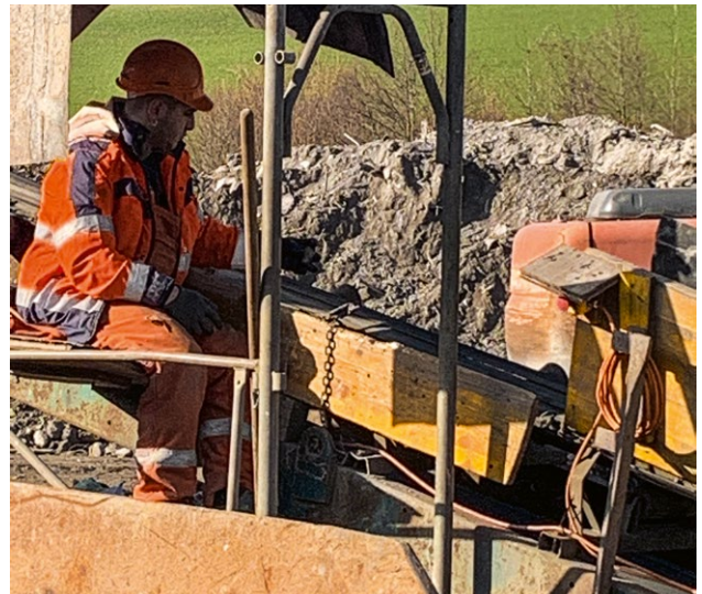
Trotz der maschinellen Trennung wird noch von Hand kontrolliert und nach Bedarf aussortiert.
