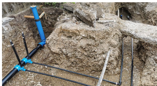
Leitungsbau Aeschstrasse / Hydrantenleitung mit zwei Hausanschlüssen.
